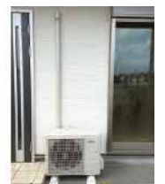
4.外機取付(完成)
