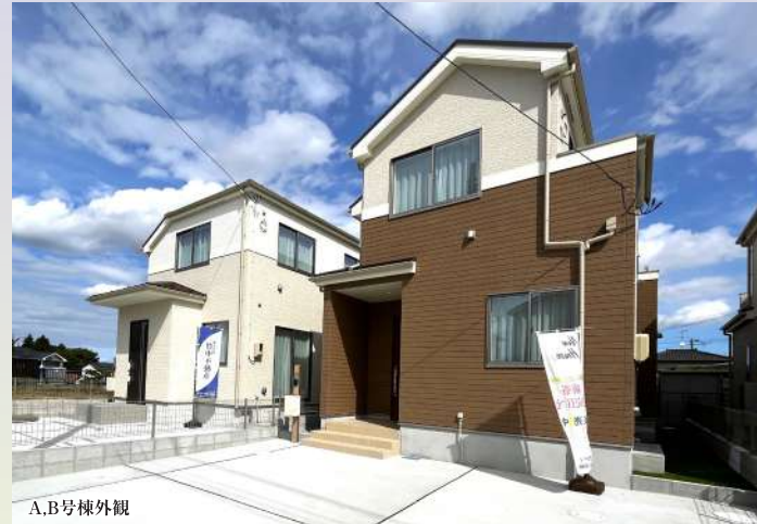
A,B号棟外観
